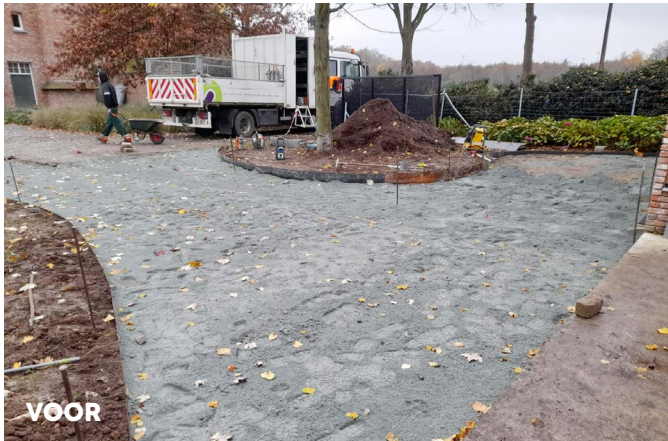
Hier was de vraag om de oprit in organische vorm aan te leggen in kasseien. De verschillende niveaus maakten het niet makkelijk om overal aansluiting te krijgen en het water te laten afvloeien.
