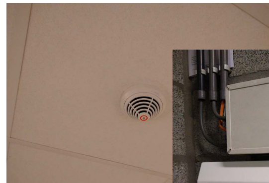
Branddetectie en gasdetectie B3 (vervanging)
