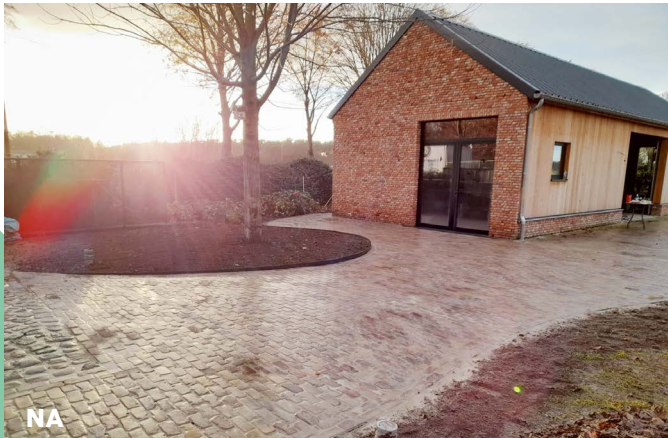
Mooi resultaat van een van onze aanlegploegen. De kasseien zijn ingewassen: minder groenaanslag en mooier egaal resultaat.
